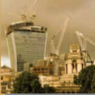
İnşaat Sektörü Construction Industry
